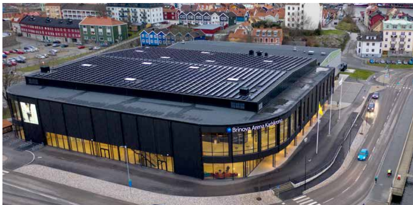
På taket till Brinova Arena i Karlskrona finns 2 000 kvadratmeter solceller. Solcellerna producerar cirka 300 000 kilowatt-timmar per år vilket ger ett överskott som säljs vidare. Under 2021 certifierades Brinova Arena som ett PHI Energisparhus.
