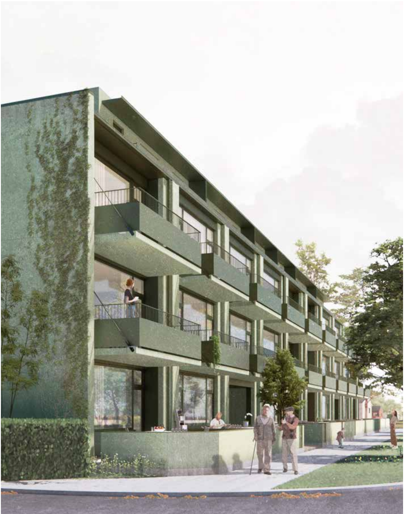
Bostadsfastighet under produktion i Staffanstorp, Hjärup som vid färdigställande kommer att bestå av 34 hyresbostäder och en uthyrningsbar yta om 2 000 kvm.
