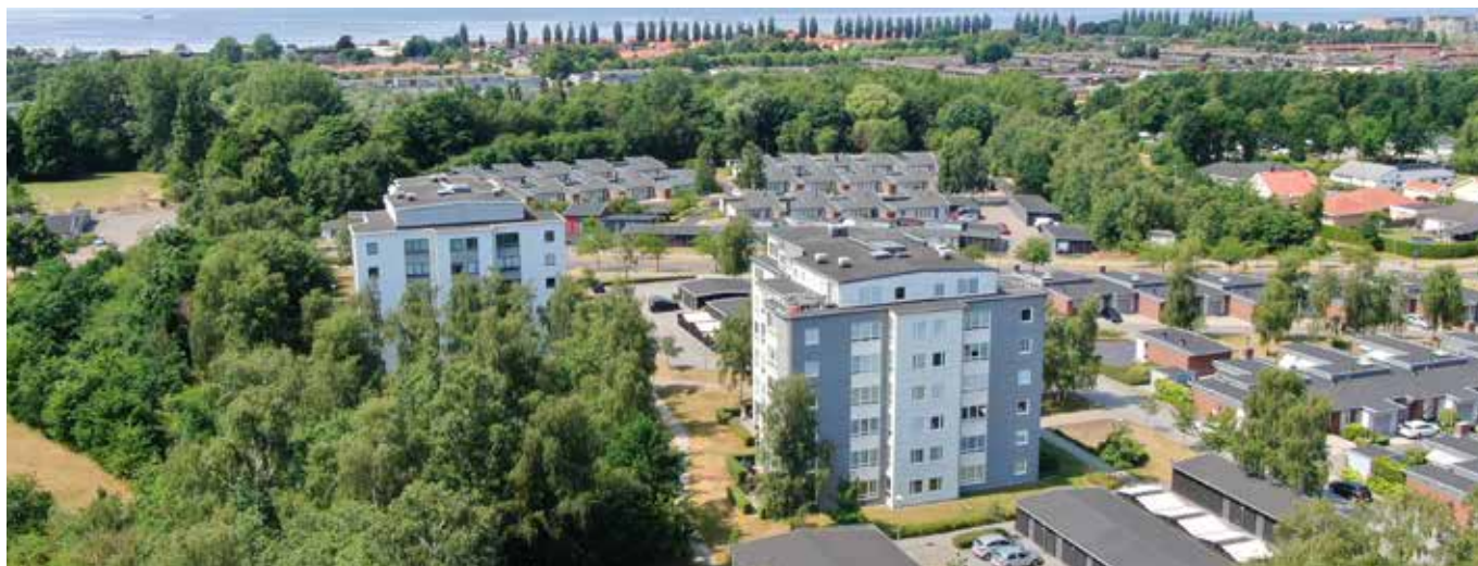
Bostadsfastigheten Klas Klättermus 2 i Borstahusen i Landskrona med 76 hyresbostäder och byggrätter om cirka 9 500 kvm BTA där Brinova planerar att uppföra 18 radhus samt två punkthus med 10 våningar, totalt 86 bostadslägenheter.
