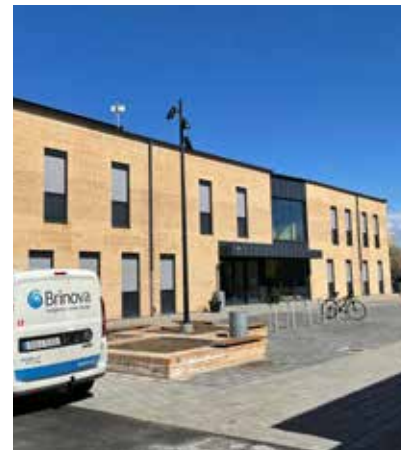
Väsby 44:565, Bara. 2020 förvärvade Brinova ett kluster av fastigheter, hyresbostäder och samhällsfastigheter, i Bara Centrum. Förutom hyresbostäder består beståndet av en idrotts-hall och ett bibliotek som förhyrs av Svedala kommun, folktandvård och livsmedelsbutik och apotek. Under 2021 har nu också en vårdcentral färdigställt som förhyrs av Region Skåne.
