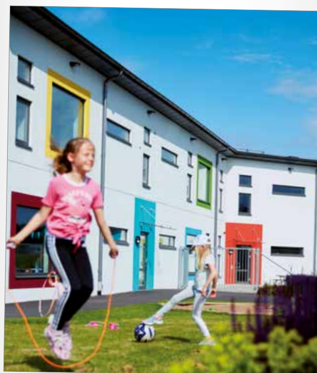
Tenoren 1, en nybyggd förskola i Helsingborg.
