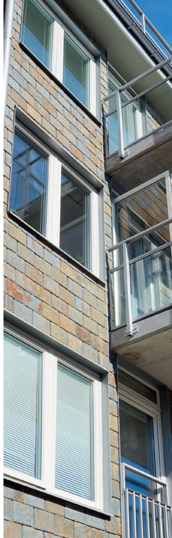
Färgaren 21, Eslöv. Huset som stod klart i slutet av 2017 har fem våningar med 39 attraktiva lägenheter. Fastigheten som är belägen nära tågstationen i centrala Eslöv erbjuder ett modernt boende till en attraktiv kostnad för de som arbetar i såväl kommunen som i de närliggande större städerna som lätt kan nås. Lika lätt når man kringliggandes städers bredare utbud av nöjen och annan service.
